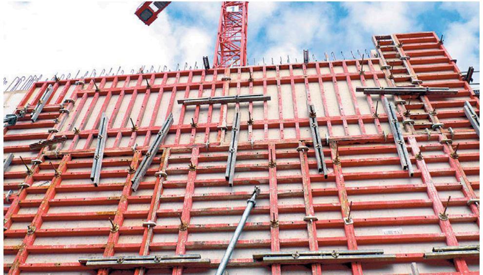
*Il progresso avanza anche nel settore edilizio: sistemi di cassetta rapida e calcestruzzi autocompattanti consentono di gettare in tempi brevissimi muri alti diversi metri. Foto: www.meva.ch*
