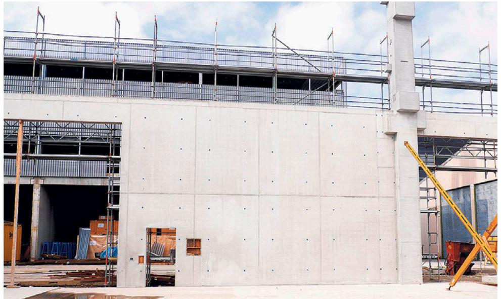
Der Fortschritt macht auch vor dem Baugewerbe nicht Halt: Diese 7,25 Meter hohe Wand mit selbstverdichtendem Beton wurde in einem Takt in einer Stunde betoniert. Bild: [www.meva.ch](http://www.meva.ch)
